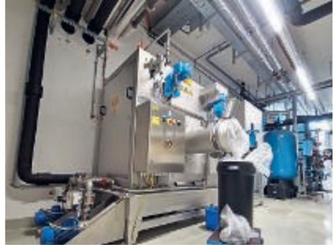
Mit dem „SmellBag“-System lassen sich abfiltrierte Flusen leicht entsorgen. Foto: ABZ Zierler
